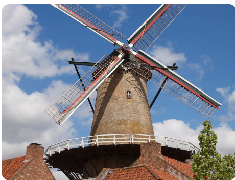
Sluis - De Brak
